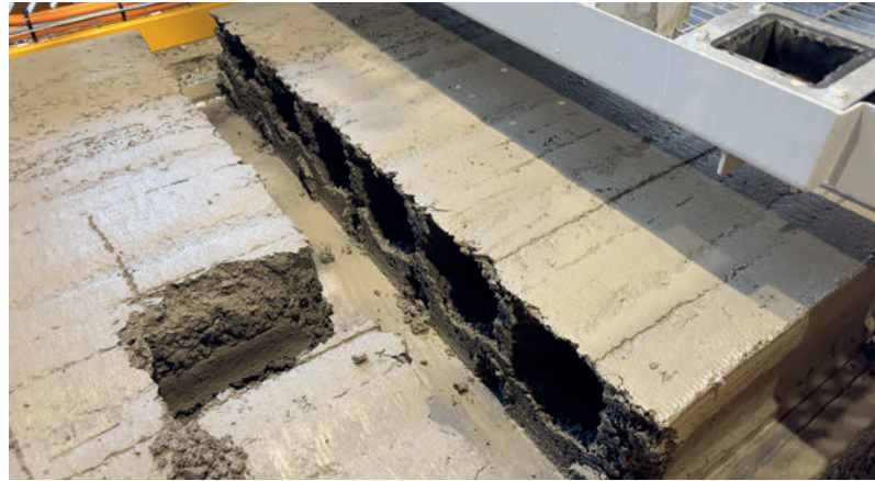
Calidad del corte recién realizado con el sistema de cortado
