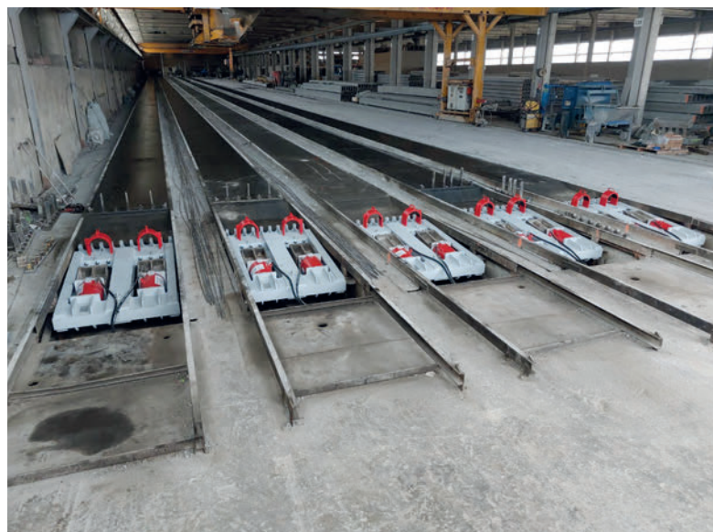
Nuevas vigas de reacción con dispositivo de destensado
