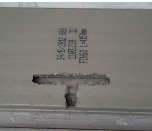
Huecos típicos en el hormigón fresco
