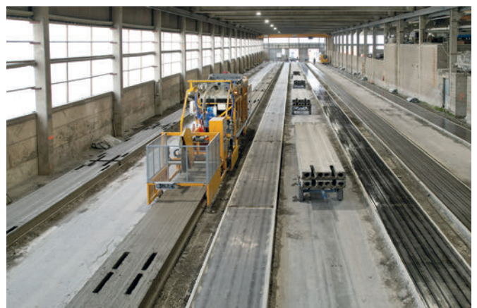
Vista interior de la planta de producción
